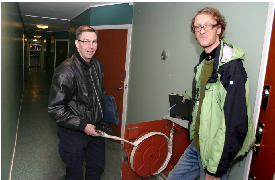
Brandinspektör Jan Tomtin på inspektionstur tillsammans med Magnus Jonsson. I varje korridor finns ett skåp med brandslang. Frågan är om den fungerar. Jan Tomtin rekommenderar en övning till sommaren för att testa vattentillgång och slangarnas täthet.
